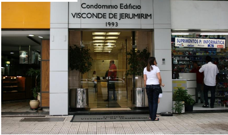
Entrada do Edifício
